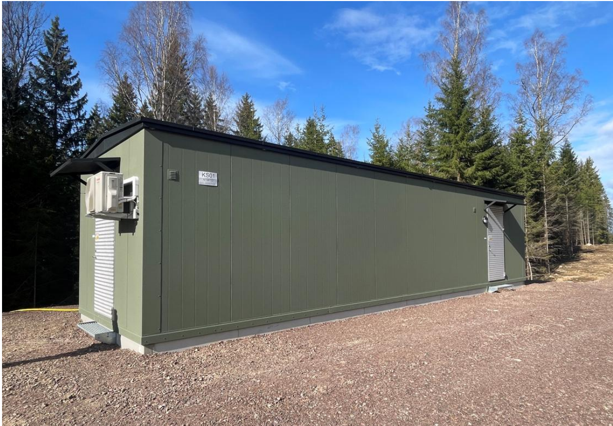
Figur 14 Kopplingsstation i vindpark (Foto: Jonas Barman)
