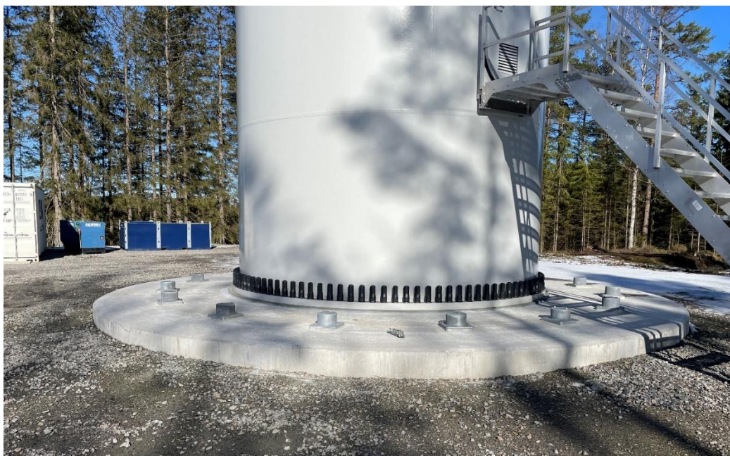
Figur 7 Fundament efter återfyllnad och montage av vindkraftverk. Foto Jonas Barman
