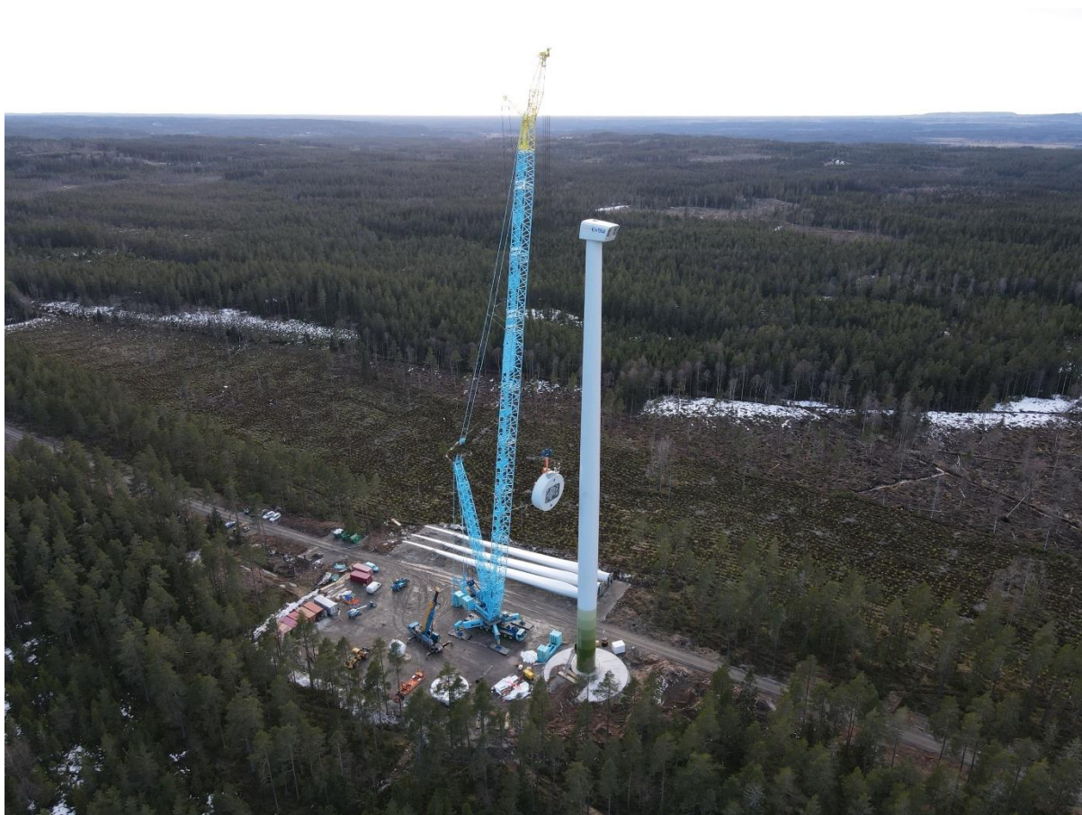
Figur 4 Foto från montering av vindkraftverk. Foto: EnBW
