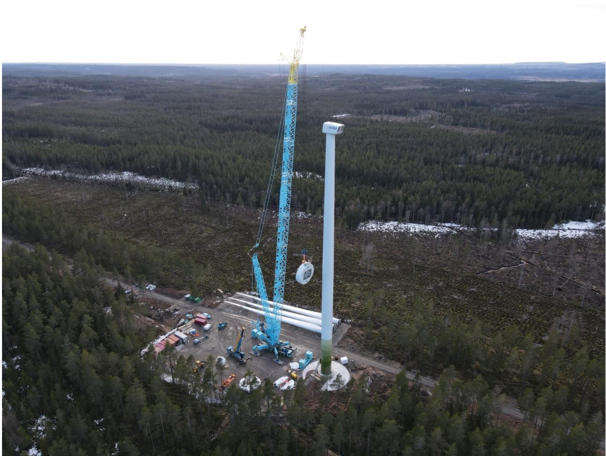
Foto från montering av vindkraftverk vid Råmmarehemmet Vindpark. (EnBW)
