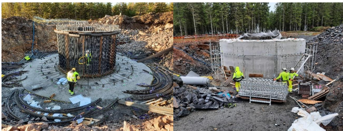
Figur 8 Bergsförankrat fundament under uppförande. Det vänstra fotot visar montage av bultkorg och början av montering av armeringen. Det högra fotot visar ett gjutet fundament Foton: Jonas Barman
