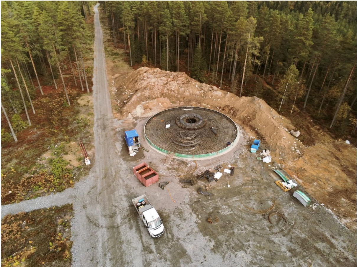
Figur 6 Gravitationsfundament under uppförande i Råmmarehemmets Vindpark. Foto EnBW.
